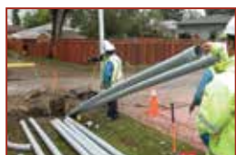
Le système Sceptacon constitue la solution idéale pour les installations avec forage sur une courte distance, lorsque la circulation locale intense ne peut être interrompue.
